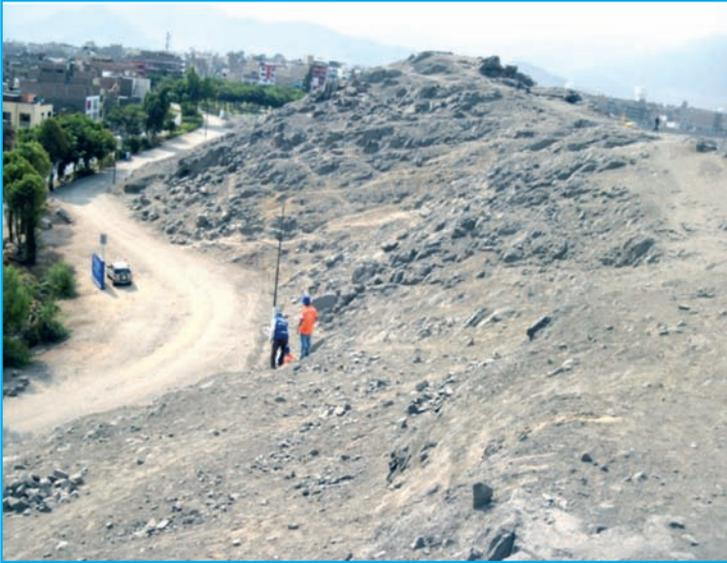
[Foto 1].- Aspecto del macizo rocoso donde se excavará el Túnel. Se aprecia una roca sana, pero con fuerte fracturación, y a la presencia fallas con caja triturada de 1 - 0,5 m de espesor.
